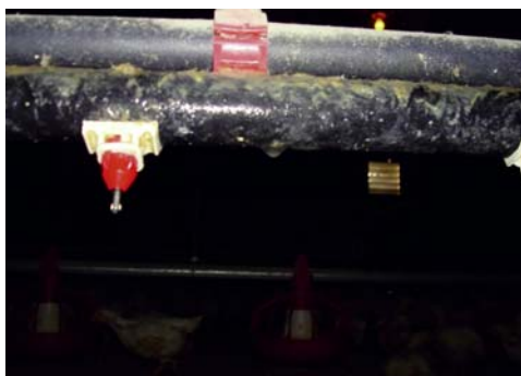
图81.8 & 81.9: 饮水管凝集有水容易滋生细菌, 右图为干净的饮水管。
